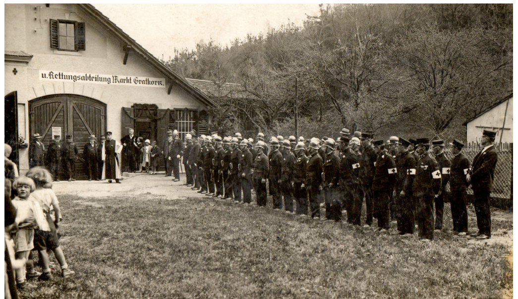
Rettungsabteilung: Im Jahre 1929 wurde ein Zubau am Rüsthaus, der als neues Rettungszimmer gestaltet wurde, angebracht und im Jahr 1930 feierlich eingeweiht.
